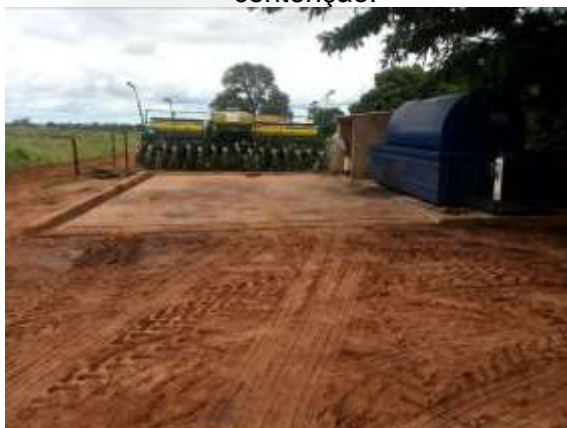
Ponto de abastecimento e Lavador. Pista em concreto canaletas e bacia de contenção.
