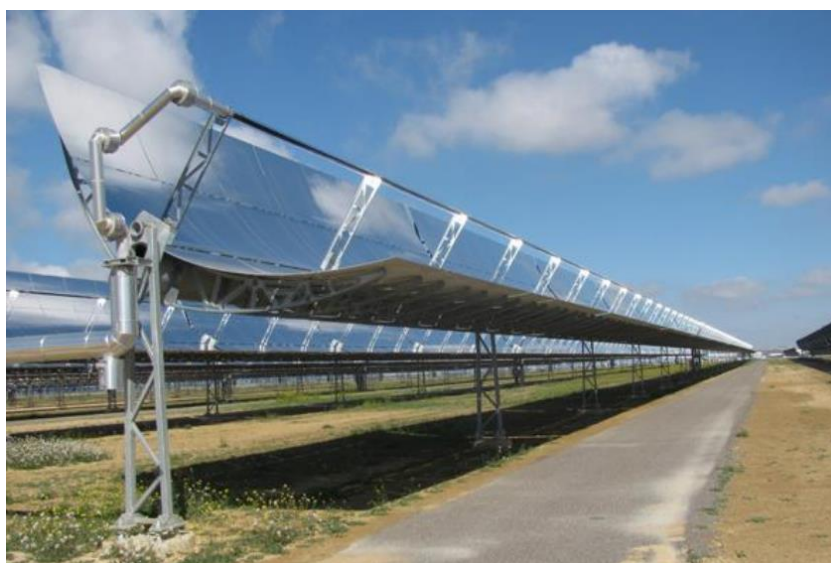
Figura 4: Sistema de Canal Parabólico Fonte: (EA, 2015).
