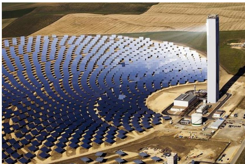
Figura 3: Sistema de Torre Solar
