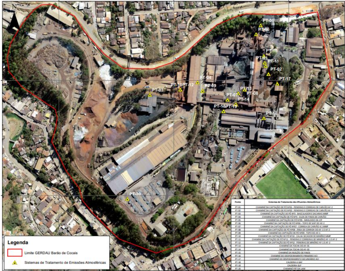
Figura 03. Localização dos sistemas de tratamento de emissões atmosféricas do empreendimento GERDAU AÇOS LONGOS S.A. - Unidade Barão de Cocais.
