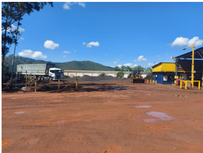
Foto 08 – Depósito de minério de ferro (Vistoria SUPRAM/LM, 2022).
