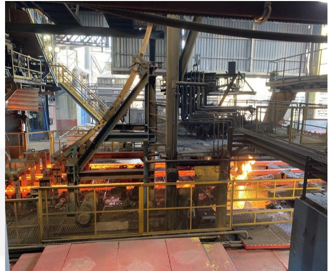
Foto 05 – Vista interna da laminação – RCA, Anexo III, 2021.
