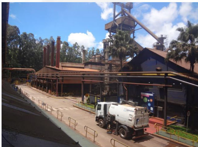
Foto 10 – Caminhão realizando varrição de rua interna do empreendimento (Vistoria SUPRAM/LM, 2021).
