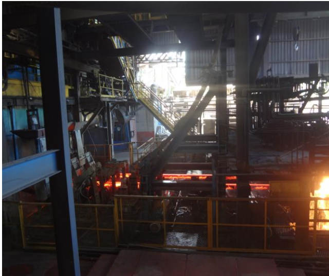
Foto 04 – Vista interna da aciaria (Vistoria SUPRAM/LM, 2021).
