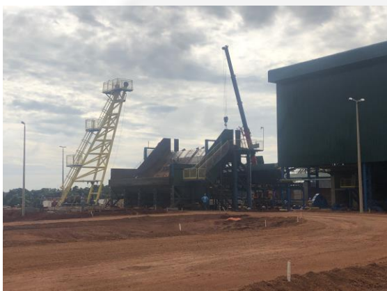
Foto 01. Descarregamento da cana de açúcar
