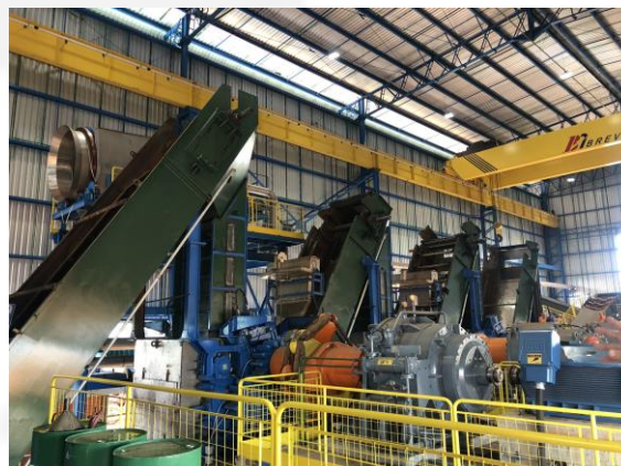
Foto 02. Novos ternos de moenda instalados
