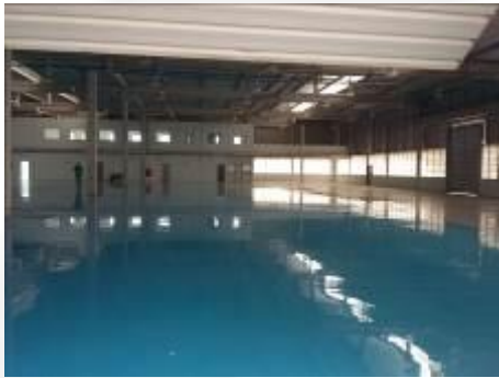
Foto 01. Vista interna do galpão existente, utilizado anteriormente por outro empreendimento.
