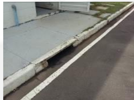
Foto 04. Drenagem pluvial já existente na área.
