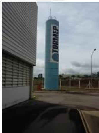
Foto 03. Caixa d'água com capacidade para 100m 3 de água.
