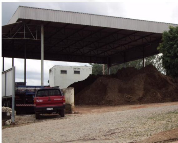
Foto 3: Depósito de argila coberto.
