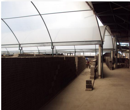
Foto 8: Estufas de secagem dos tijolos.
