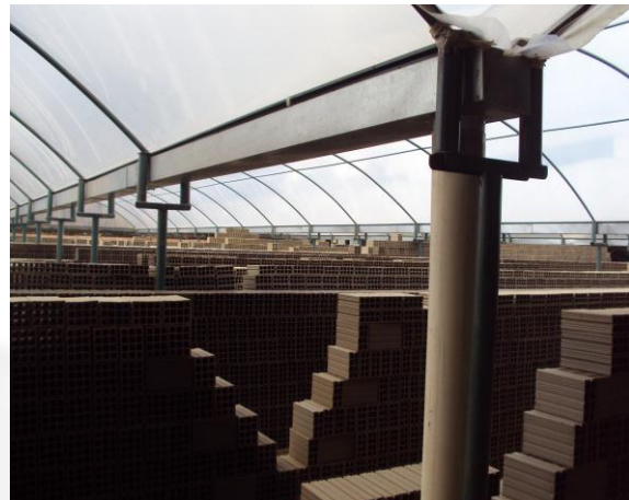
Foto 11: Calhas do sistema de drenagem pluvial.
