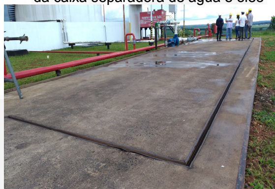
Foto 04. Local de instalação da nova plataforma de carga/descarga.
