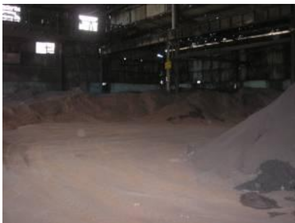
Foto 01: Galpão de armazenamento de matéria-prima.
