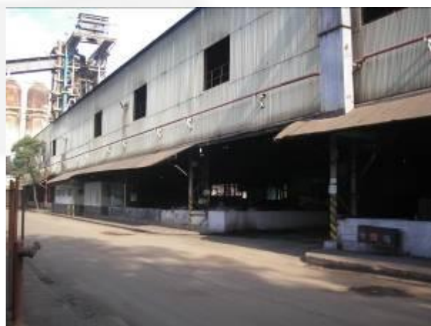
Foto 06: Visão externa do empreendimento.
