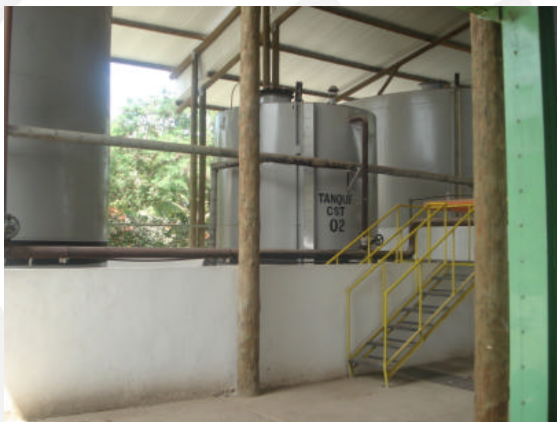
Foto 10-Bacia de Contenção dos Tanques
