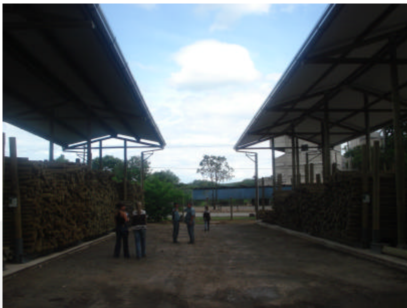
Foto 11-Galpões de Estocagem da Madeira Após Tratamento
