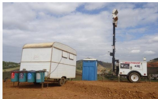
Figura 11: Unidade de apoio.
