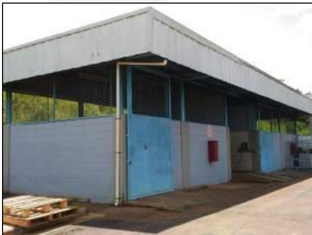
Foto 07. Depósito temporário de resíduos
