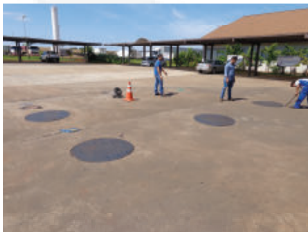
Foto 03. Área de tanques da pista de veículos leves
