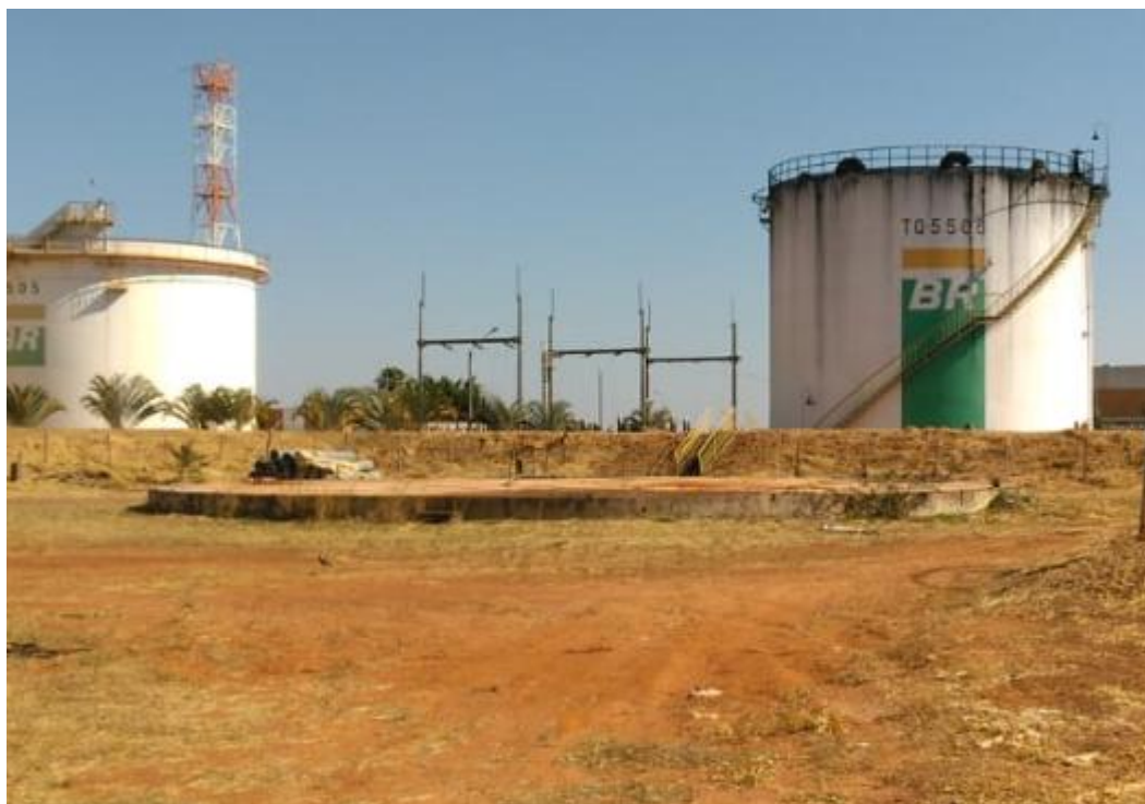
Foto2- Situação do tanque de 5.000 m³ (somente a base de concreto instalada).
