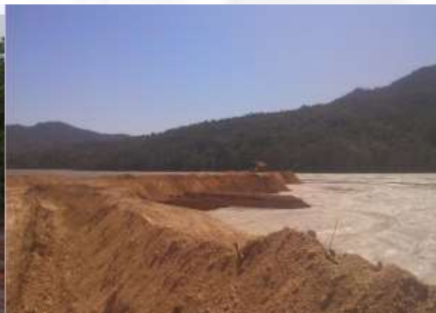
Figura 2: Canal aberto para direcionamento do rejeito entre os setores do reservatório. Fonte: EIA (Vale, 2018) Figura 3: Leira direcionadora de fluxo. Fonte: EIA (Vale, 2018)
