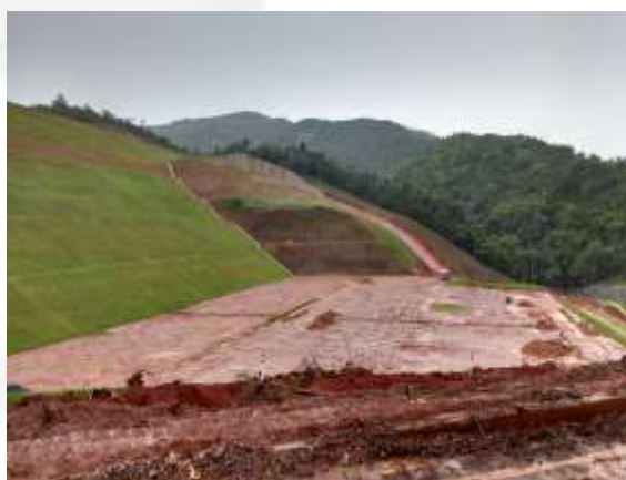
Foto 02. Maciço, vertedouro e instalação de drenos.
