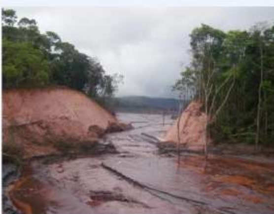
Figura 2: Canal aberto para direcionamento do rejeito entre os setores do reservatório. Fonte: EIA (Vale, 2018) Figura 3: Leira direcionadora de fluxo. Fonte: EIA (Vale, 2018)
