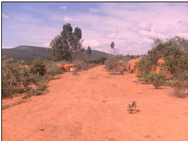
Foto 13: Área do canteiro de obras
