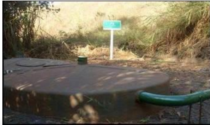
Figura 15: Sistemas separadores de óleos e água nas oficinas de manutenção de máquinas e veículos, utilizando-se de separadores físicos
