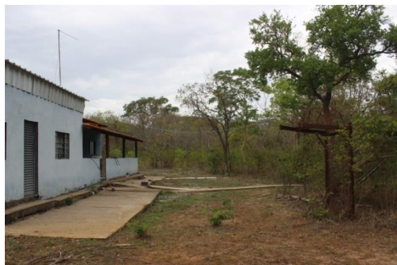
Foto 6: Casa parcialmente na APP do Rio Paracatu
