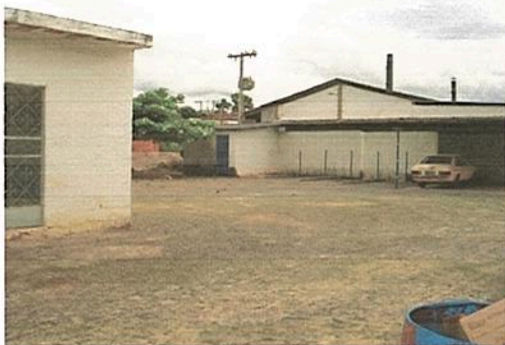
Fotografia 1 – Entrada do empreendimento.
