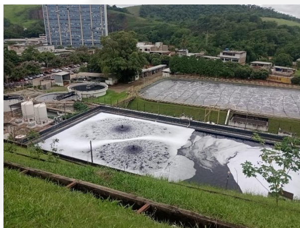
Foto 09. Vista geral da ETE
