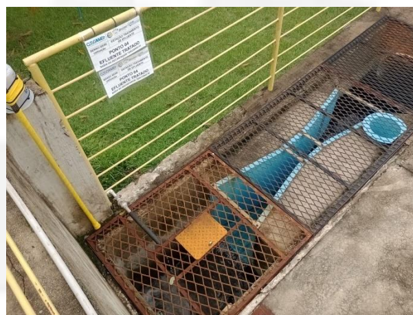
Foto 12. Saída da ETE
