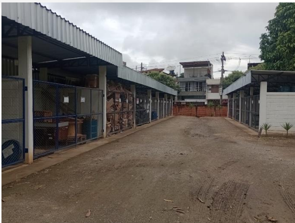
Foto 13. Depósito temporário de resíduos
