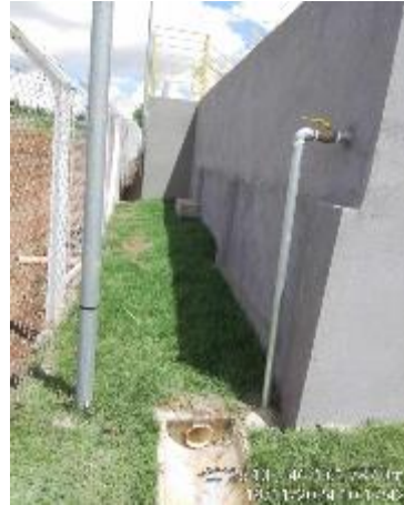
Foto 08. Saída bacia contenção dos tanques.
