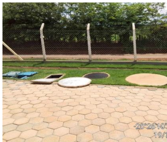
Foto 06. Sistema separação água/óleo.
