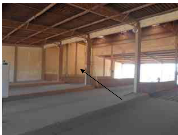
Foto 06. Local do novo tombador de grãos
