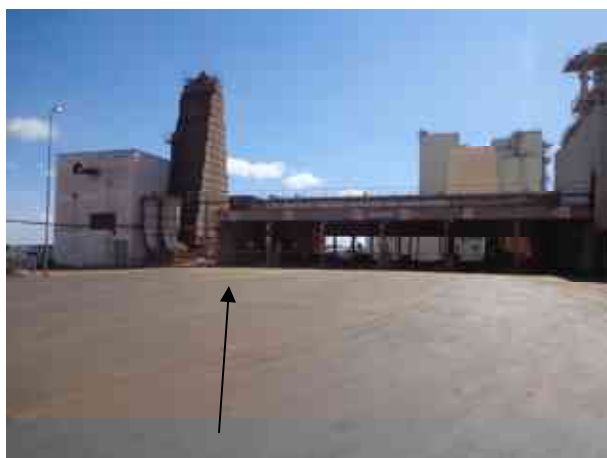
Foto 05. Local do novo tombador de grãos
