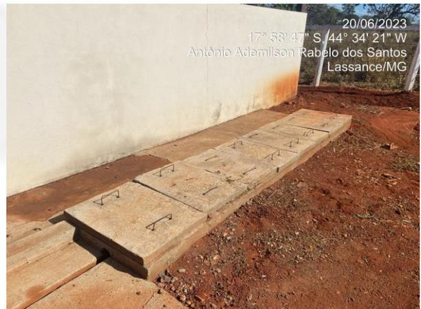
**Foto 2: Caixa separadora de água e óleo da área de abastecimento.**
