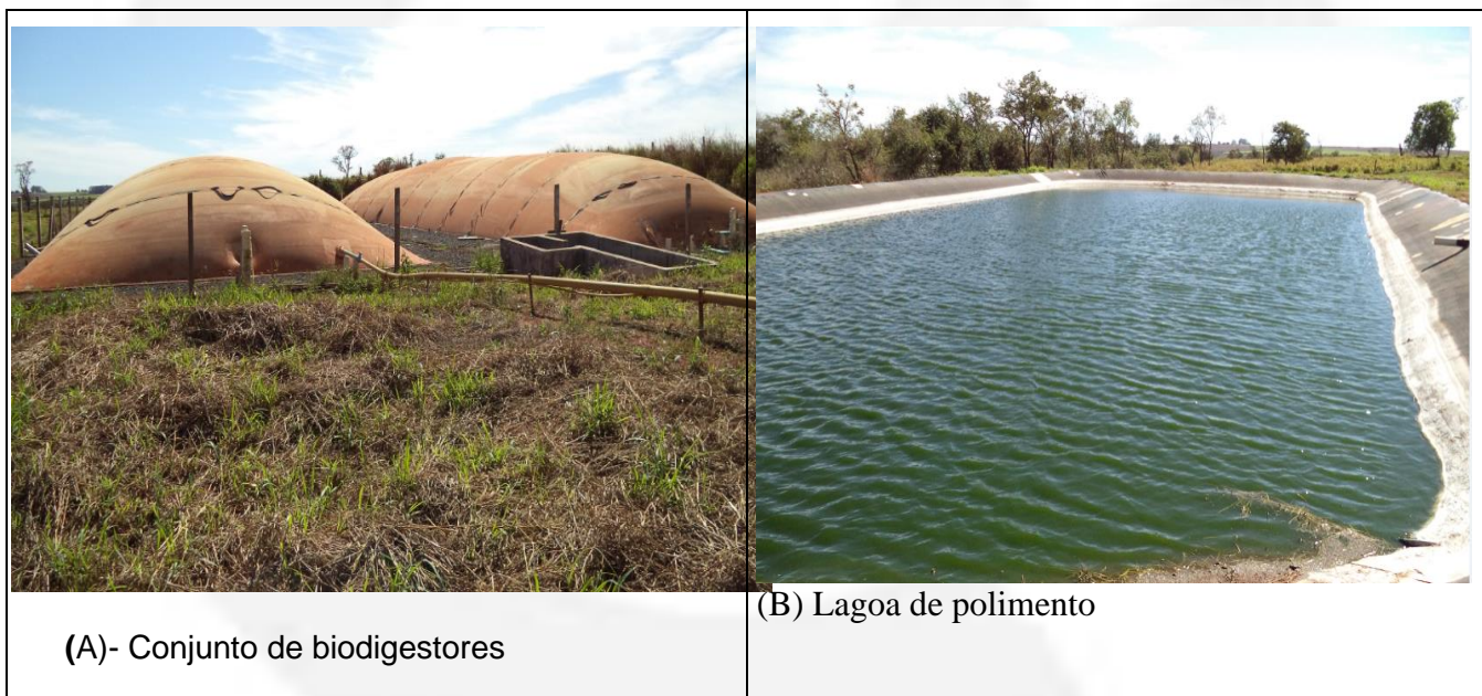
Figura 01 – Sistema de tratamento de efluentes da suinocultura
