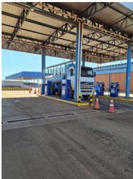
Pista de abastecimento
