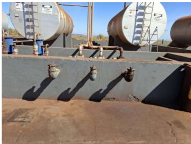
Tanques aéreos com bacias de contenção.
