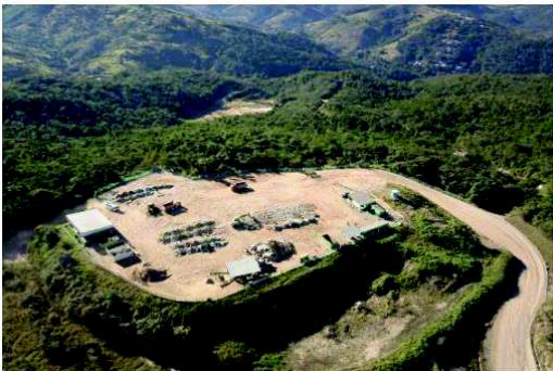
Foto 23. Vista geral – ATT RCC
