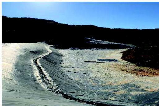
Foto 09. Descidas hidráulicas
