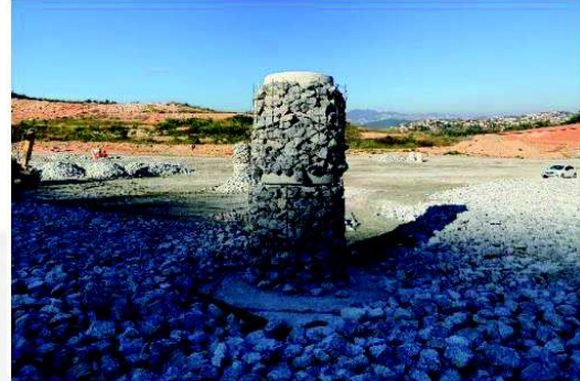
Foto 14. Drenagem de biogás
