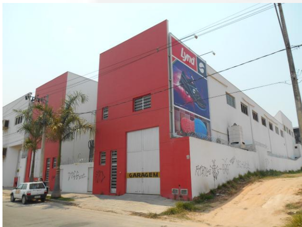
Foto 01. Fachada do empreendimento
