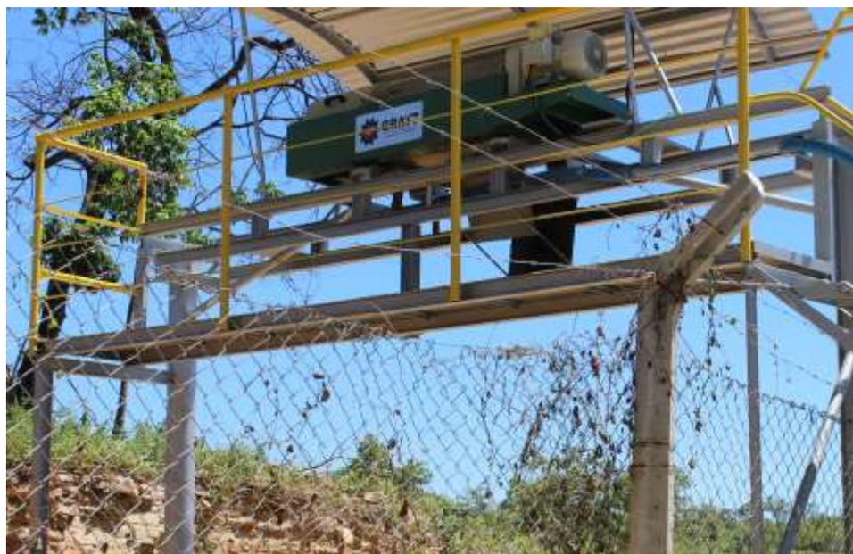
**Figura 11.** Decantador centrífugo da ETE.
