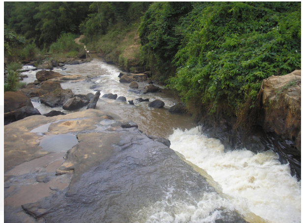
Foto 2: Futuro trecho de vazão reduzida – TVR.
