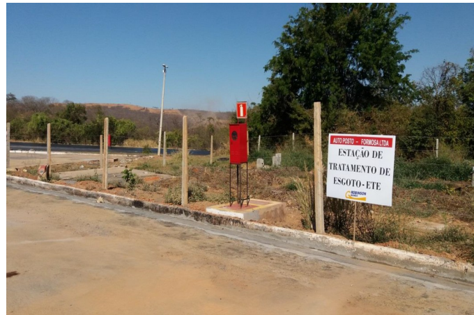
Foto 6: Área da fossa séptica, filtro anaeróbio e sumidouros
