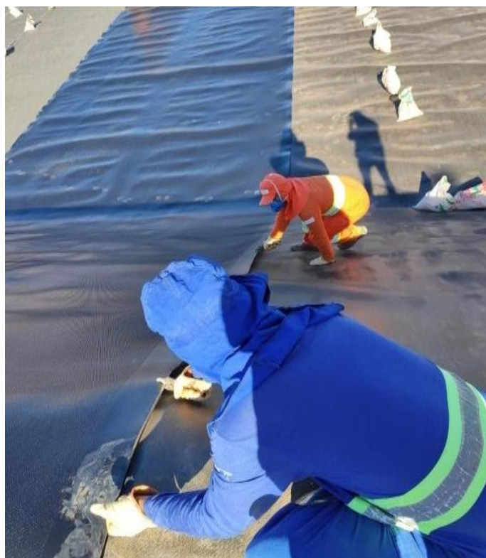
FIGURA 09 – Geomembrana de PEAD sendo instalada em unidade operacional da UVS VIASOLO MONTES CLAROS
