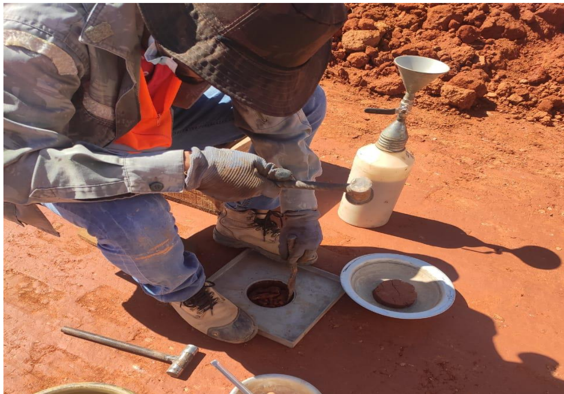
FIGURA 04 – Ensaio para controle de compactação realizado na unidade operacional da UVS VIASOLO MONTES CLAROS.
