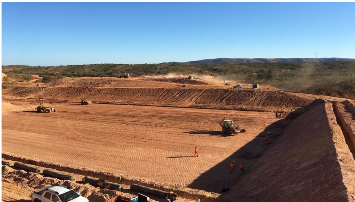
FIGURA 02 – Compactação de solo (corte + escarificação + nivelção de terreno) realizado na unidade operacional da UVS VIASOLO MONTES CLAROS.
