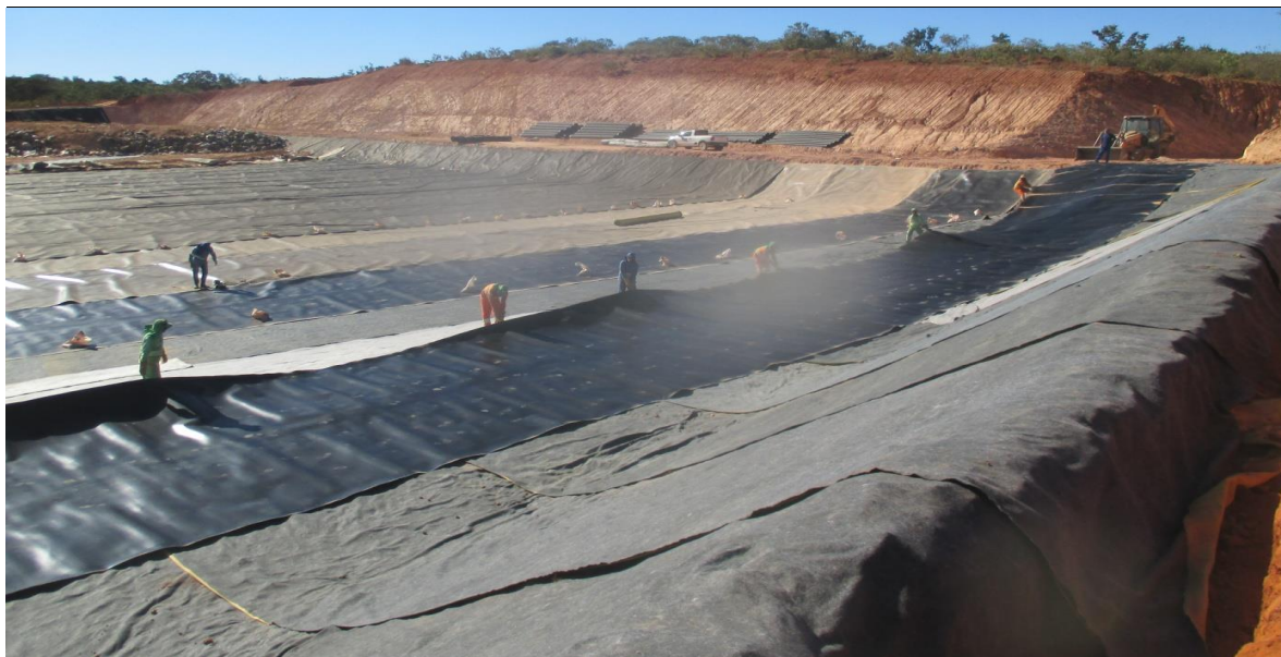
FIGURA 08 – Sistema de impermeabilização de base e taludes (solo compactado + GCL + geomembrana de PEAD) sendo instalados na fundação da Unidade de Aterragem da UVS VIASOLO MONTES CLAROS.
