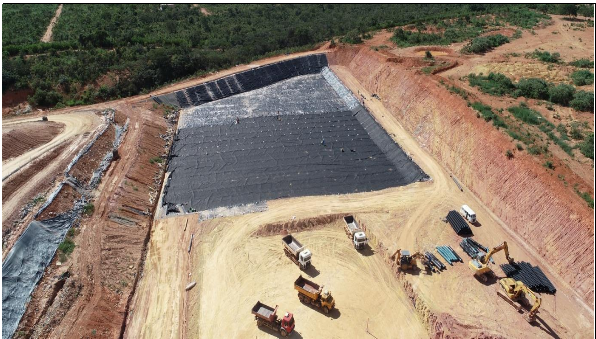
FIGURA 07 – Sistema de impermeabilização de base e taludes (solo compactado + GCL + geomembrana de PEAD) sendo instalados na fundação da Unidade de Aterragem da UVS VIASOLO MONTES CLAROS.
