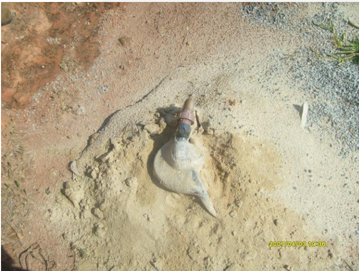
Imagem 4: Poço tubular profundo
