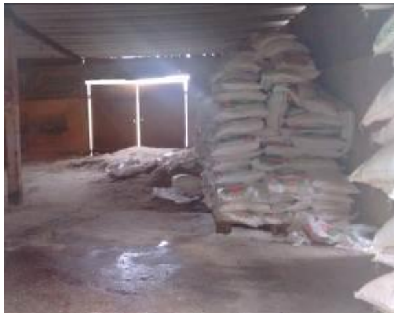
Foto 05. Casa de salga do couro
