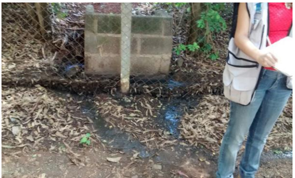
Foto 10: Vazamento de caixa de passagem na suinocultura.
