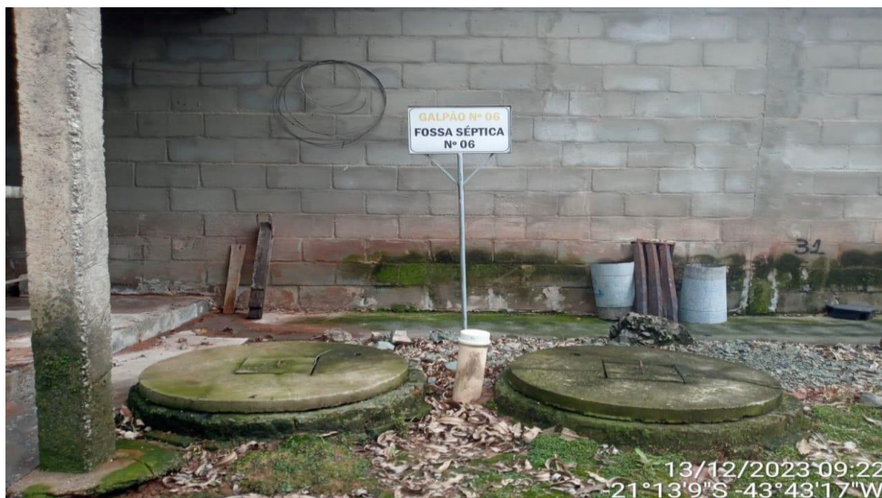
Imagem 1 – Fossa séptica, filtro anaeróbico e sumidouro.
