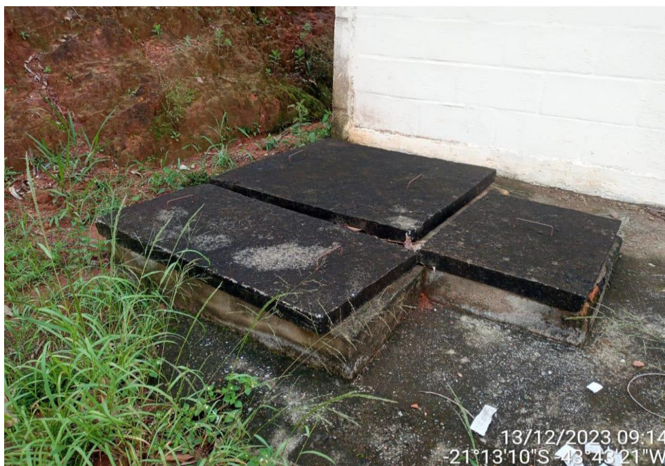
Imagem 2 – CSAO para tratamentos dos efluentes oleosos, oriundos do ponto de abastecimento.
