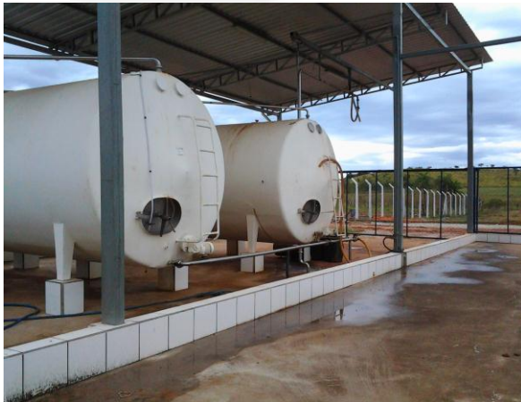
- Tanques de armazenamento de leite
