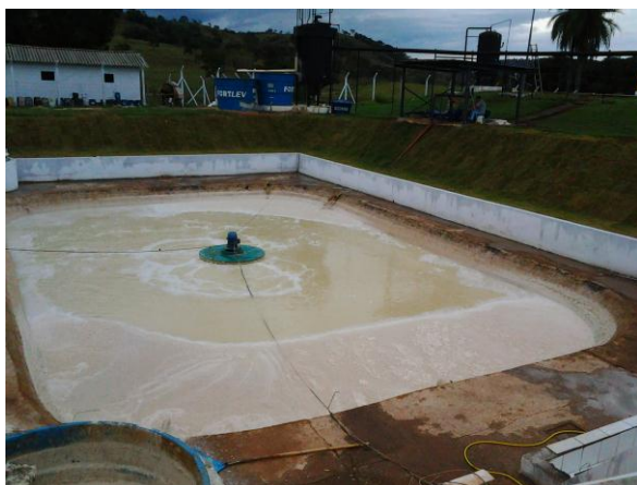
- Lagoa de tratamento
