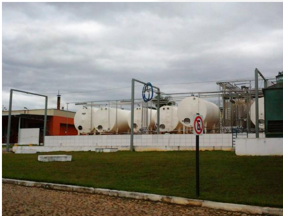
- Tanques de armazenamento de leite
