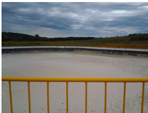
- Lagoa de tratamento
