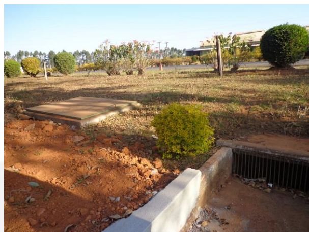
Foto 06. Drenagem pluvial e caixa de inspeção
