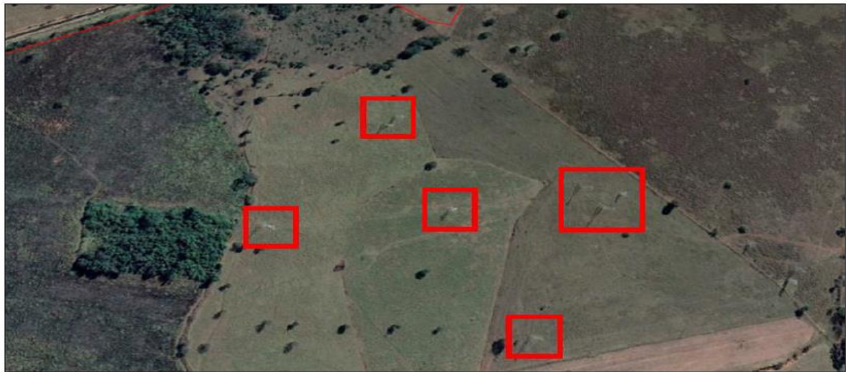
Figura 1 - Terreno de terceiro com concentração de estruturas (torres e linhas em destaque) de transmissão de energia
