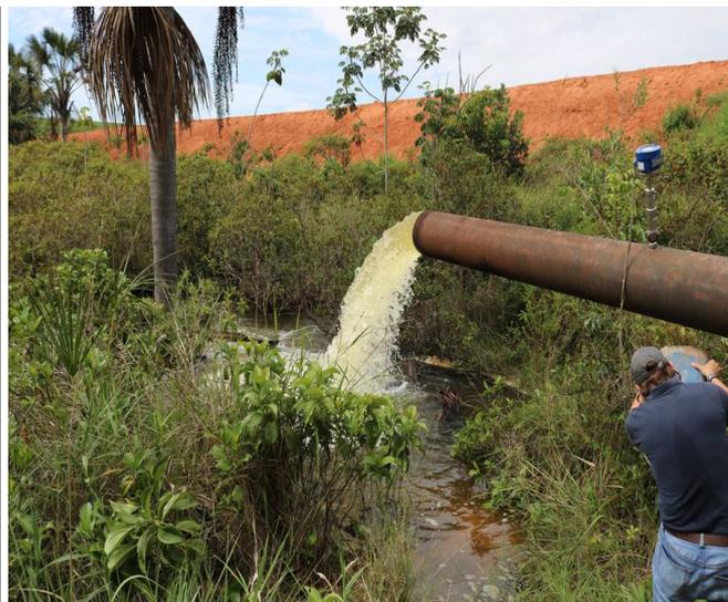
**Foto 02.** Descarga de fundo do barramento com sistema de medição de vazão.
