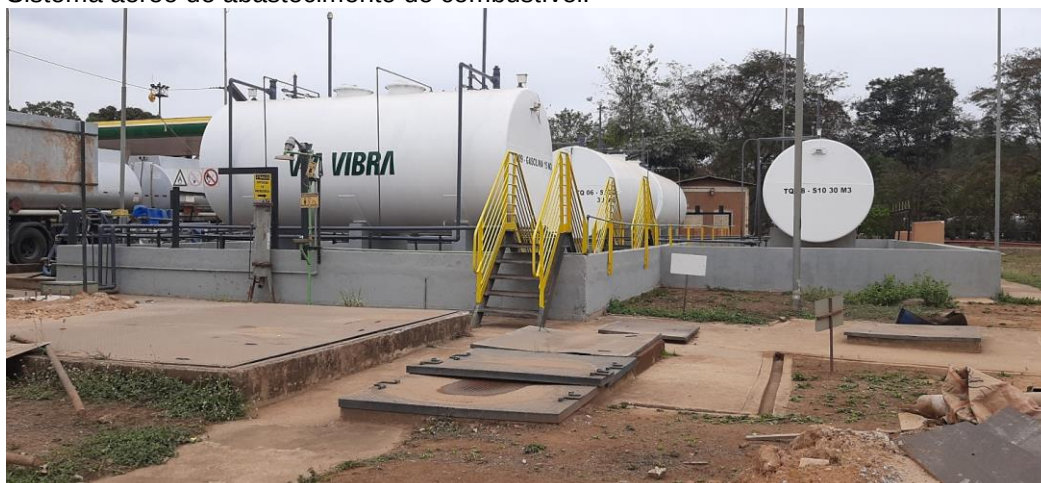
Figura 04 – Sistema aéreo de abastecimento de combustível.
