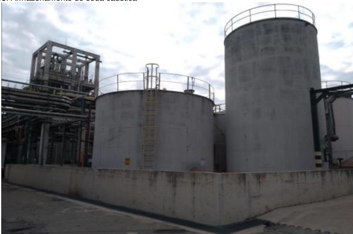
Figura 05. Armazenamento de soda cáustica
