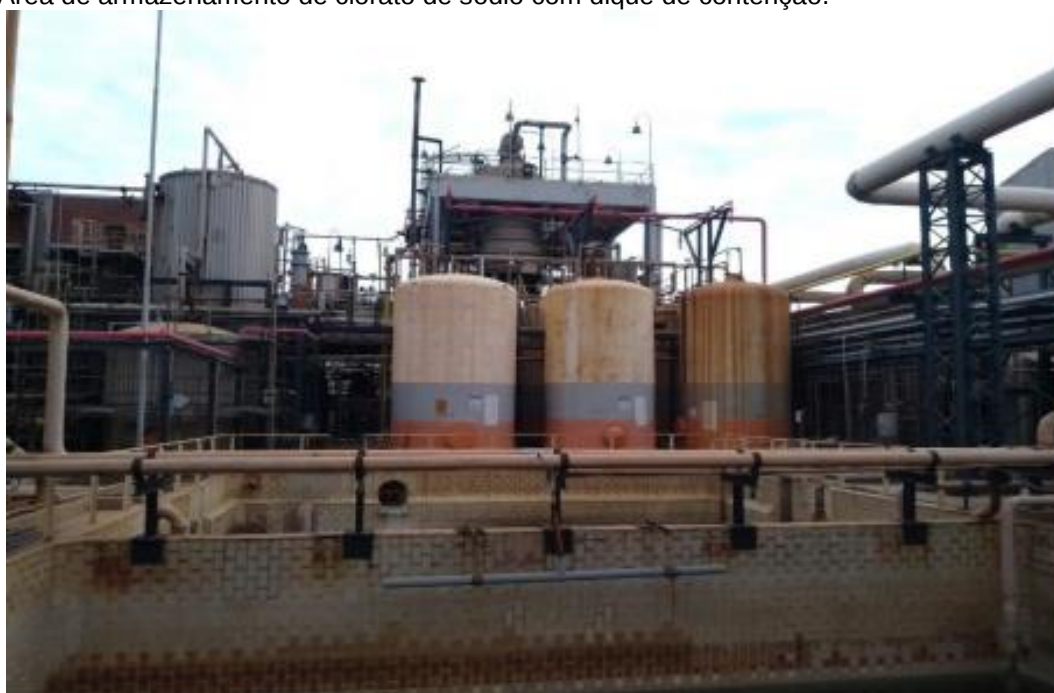
Figura 09. Área de armazenamento de clorato de sódio com dique de contenção.
