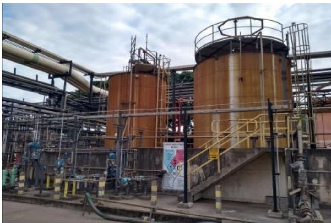
Figura 09. Área de armazenamento de clorato de sódio com dique de contenção.
