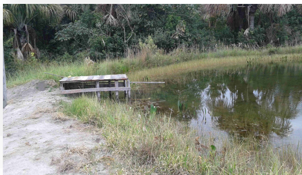
Foto 7. Captação em surgência
