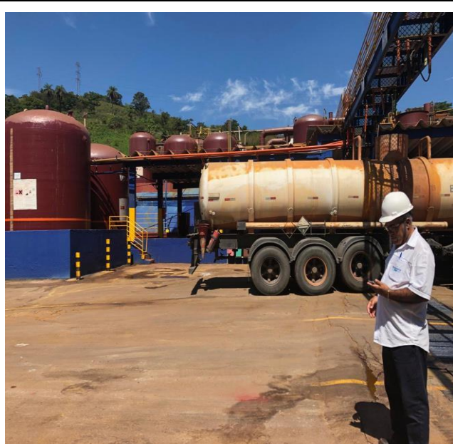
Foto 01. Área de carregamento de produto.
