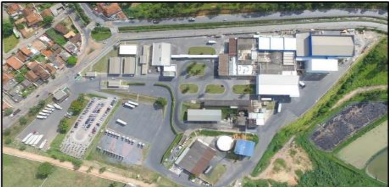
Figura I – Imagem da unidade industrial Vibra Agroindustrial S.A. zona urbana de Sete Lagoas
