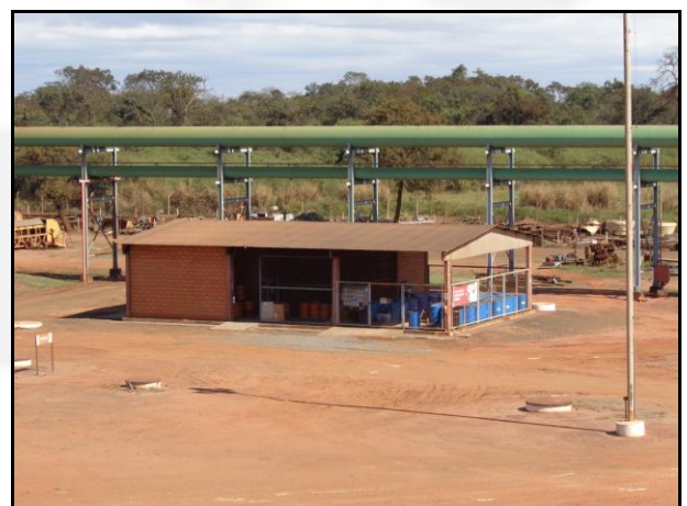
Figura 9: Área de armazenamento temporário de resíduos
