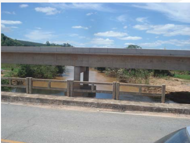
Foto 03. Nova ponte sobre a BR381.
