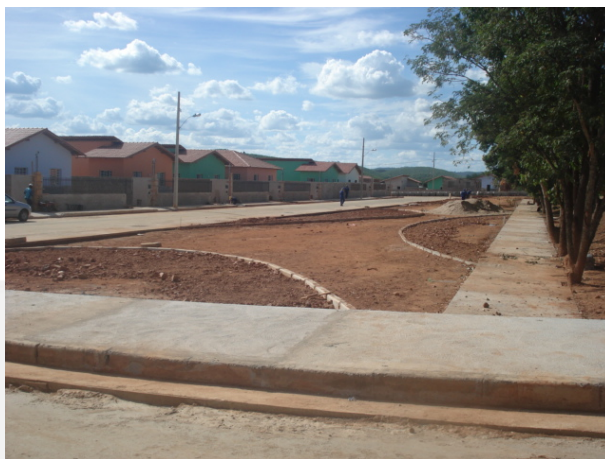
Foto 06. Realocação dos moradores da rua Francisco Diniz.
