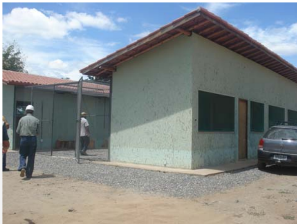
Foto 02. Centro de triagem de fauna.
