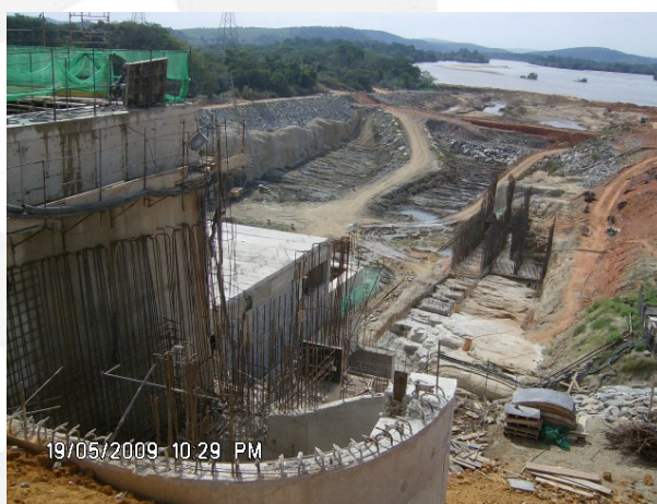
Foto 08. Sistema de Transposição de Peixes e canal de fuga.
