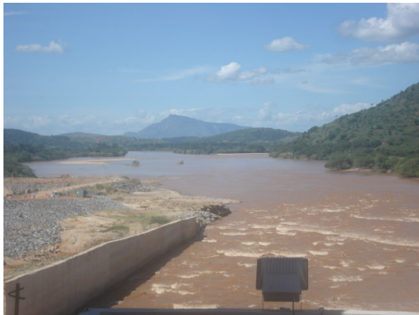
Foto 09. Trecho de vazão reduzida.
