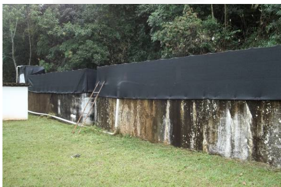
Foto 07. Caixa d'água principal.
