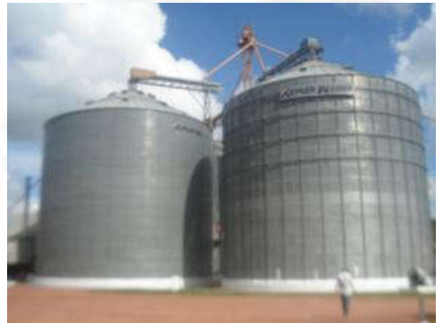
Foto 02. Silos de armazenamento
