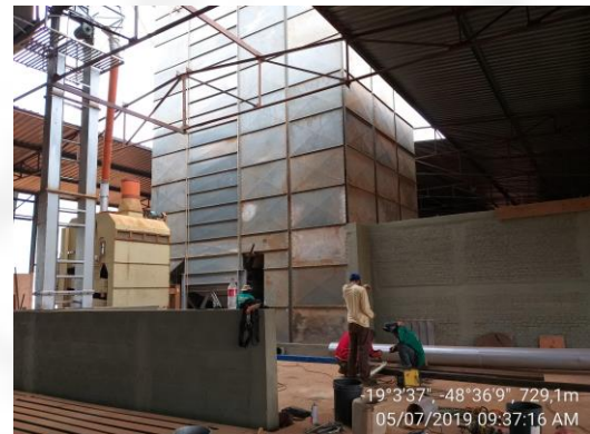
Foto 02. Instalação de estruturas da atividade de beneficiamento primário de produtos agrícolas
