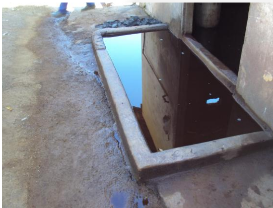
- Galpão com lâmina d'água
