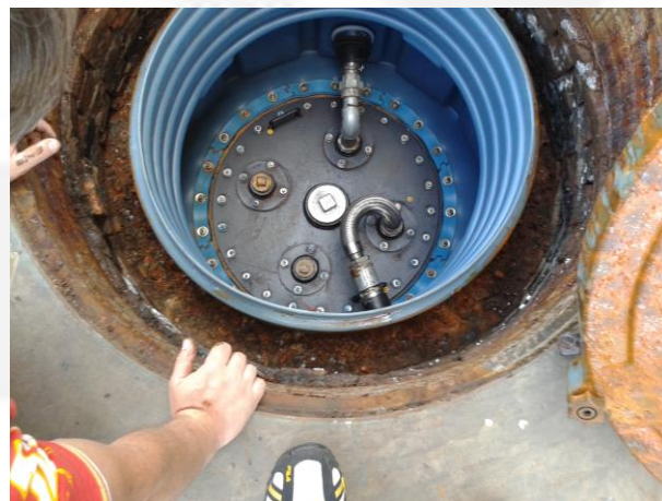
Foto 04. Câmara de acesso ao tanque
