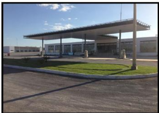
ÁREA DE ABASTECIMENTO – PISTA GASOLINA E ETANOL
