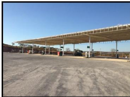
ÁREA DE ABASTECIMENTO – PISTA DIESEL
